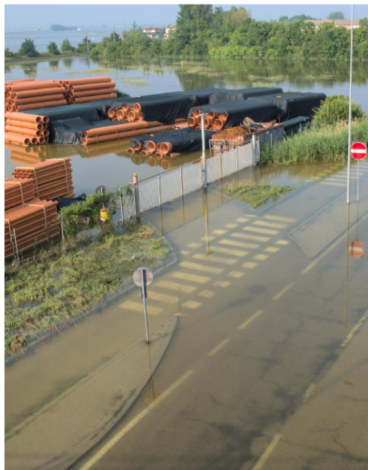
L'allagamento di un'azienda a Fornace Zarattini, a Ravenna
